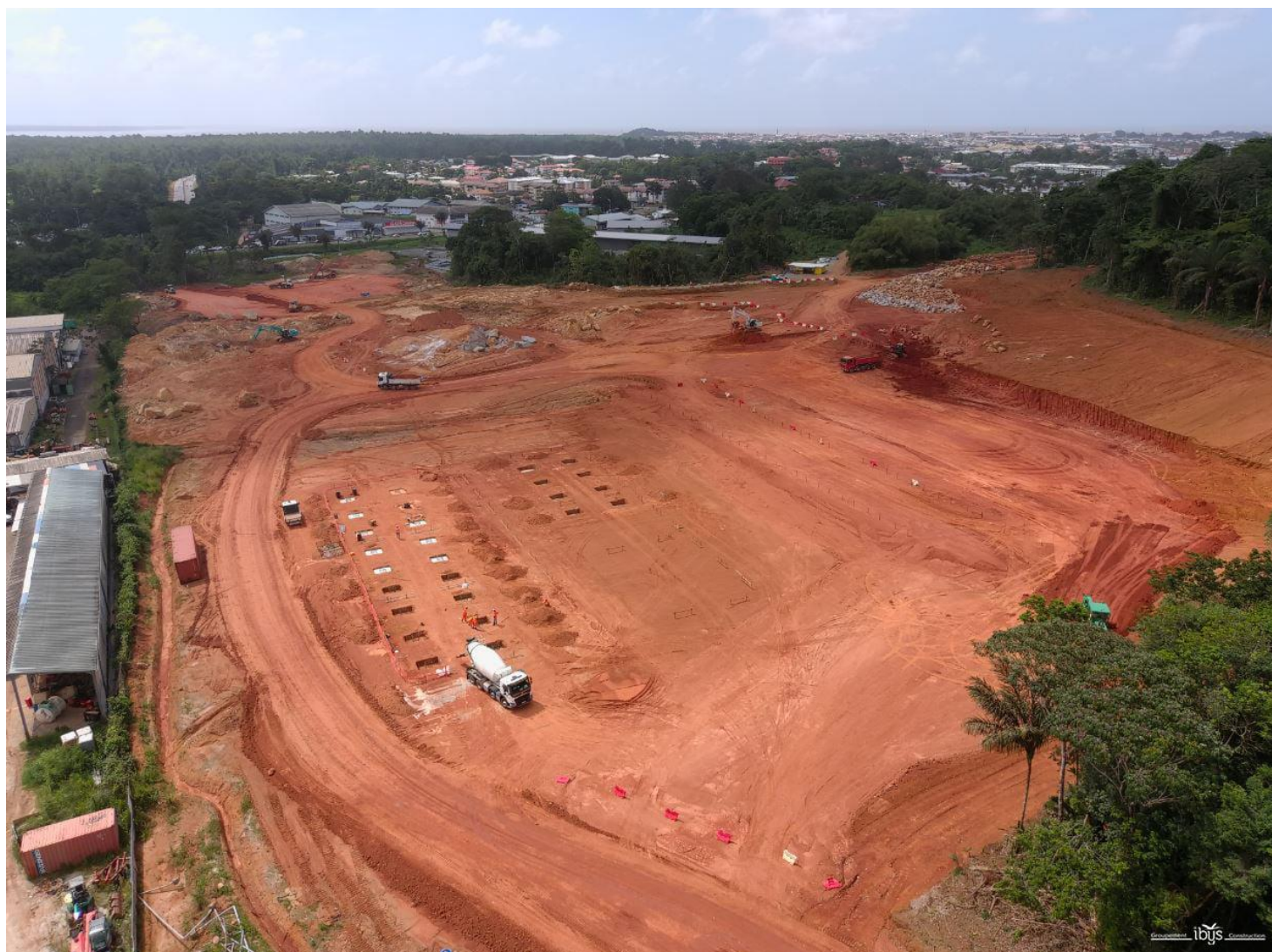
Secteur 0 – Maringouins : futur Centre de Maintenance et de Remisage (CMR)
