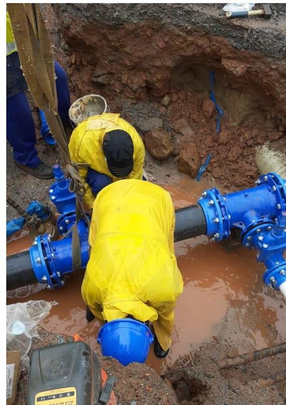
Figure 4: Intervention sur la canalisation au droit de l'intersection (reprise des maillages existants)
