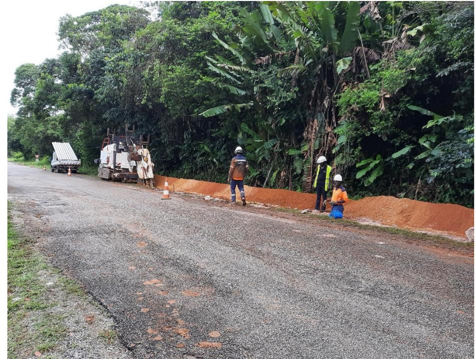
Figure 2: Pose de la canalisation PVC DN 200 en accotement de la RD 191
