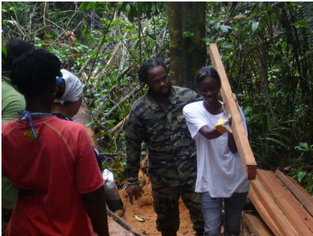
Chantier de l'ACI, Macouria, 14/12/2010
