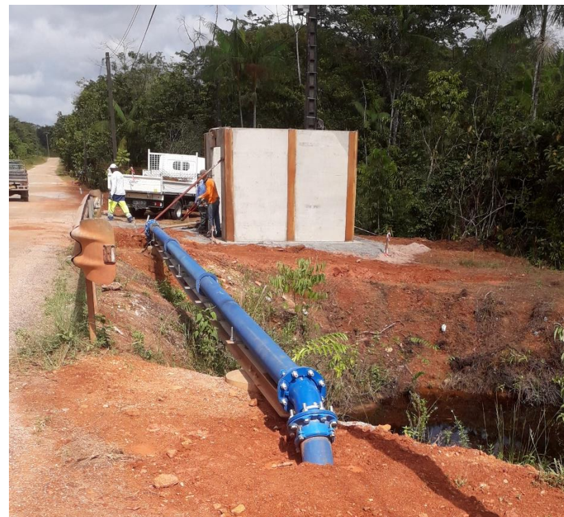
Figure 5: Mise en œuvre d'un passage de cricque en encorbellement et du local pour le surpresseur (en arrière-plan) dans le cadre du chantier Risquetout Ouest
