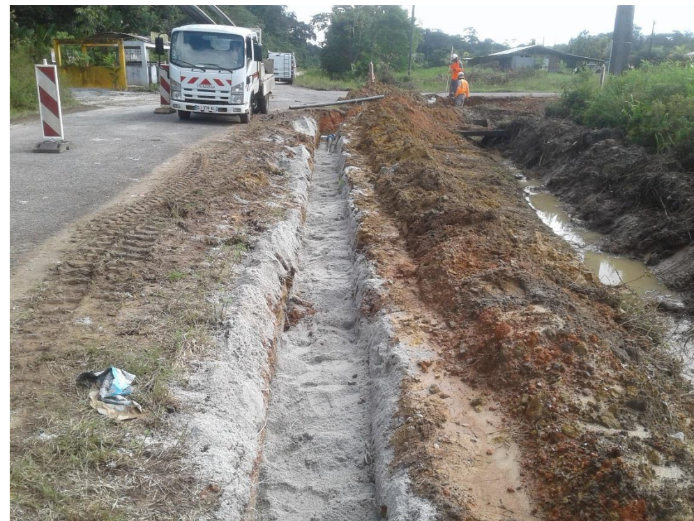
Figure 3: Travaux d'extension du réseau eau potable - secteur Trois Rois à Macouria
