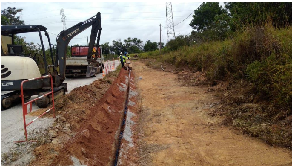
Figure 6: Travaux de mise en œuvre de la canalisation AEP PVC DN 75 mm dans le cadre de l'opération "Entrée usine de Matiti"
