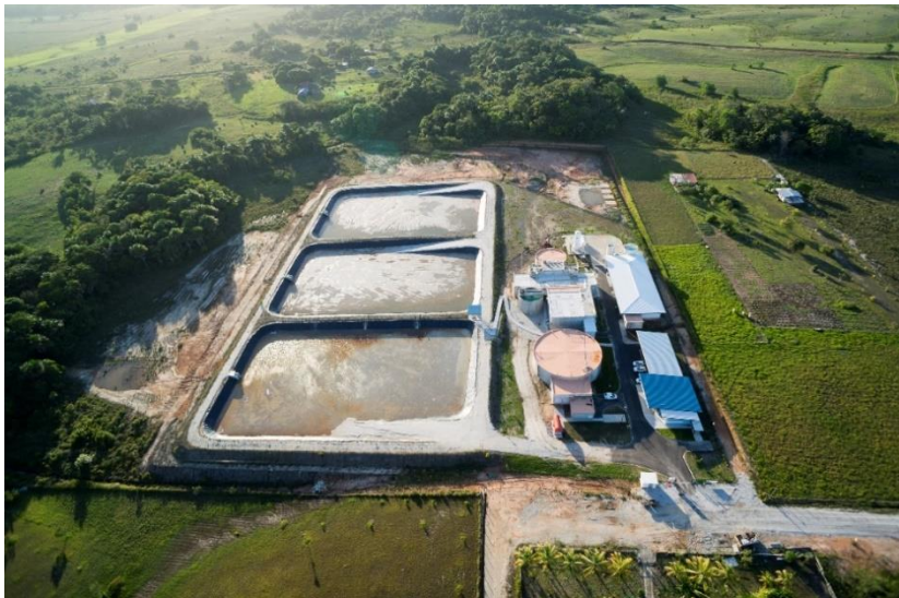
Figure 14: Vue aérienne de l'usine de potabilisation de Matiti
