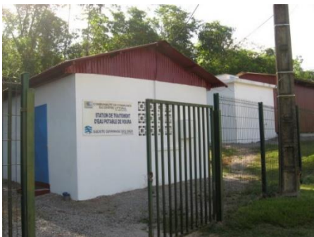
Figure 17: Usine de potabilisation du bourg de Roura
