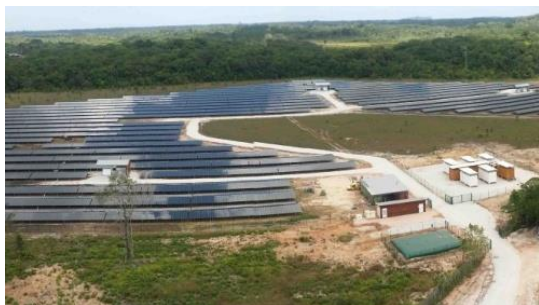
Centrale Toucan, Montsinéry-Tonnégrande
