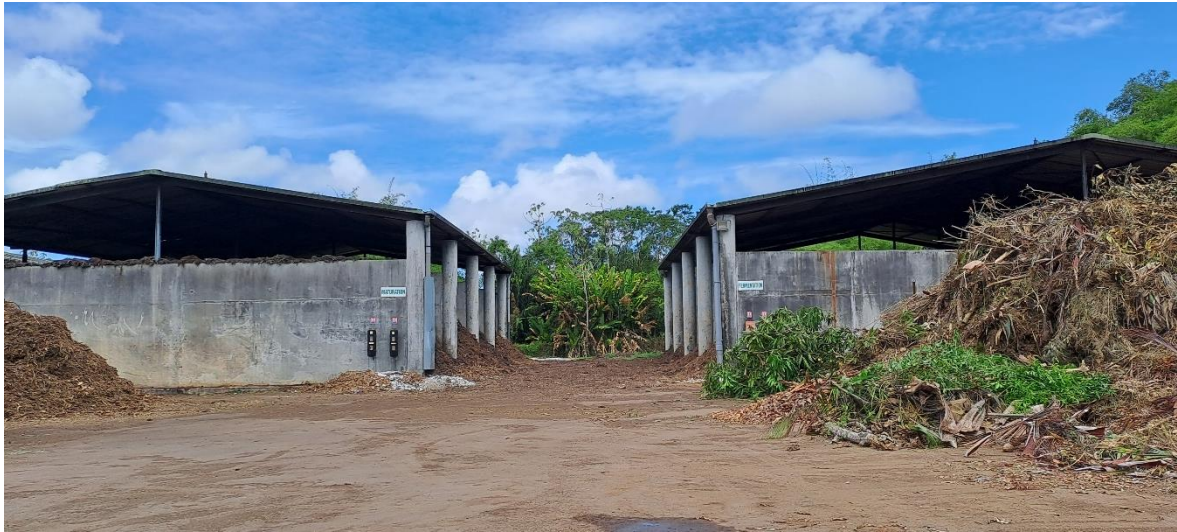
Photo : Casiers de fermentation et maturation de la plate-forme de compostage
