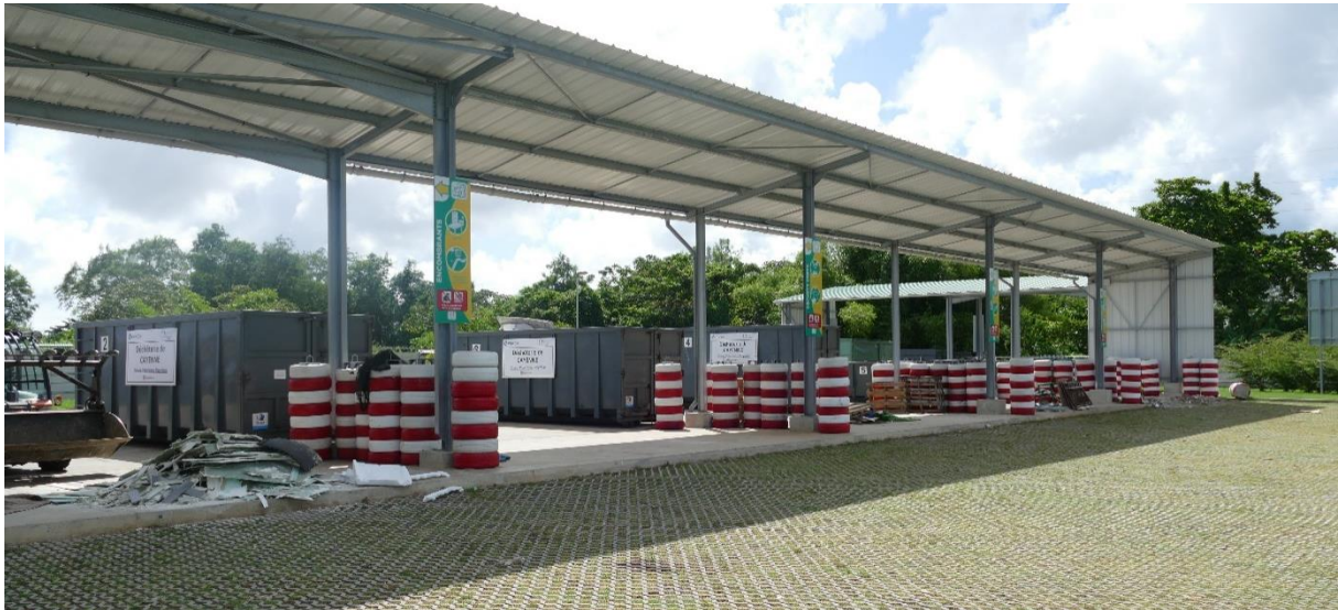
Photo : Casiers couverts de la déchetterie de Cayenne
